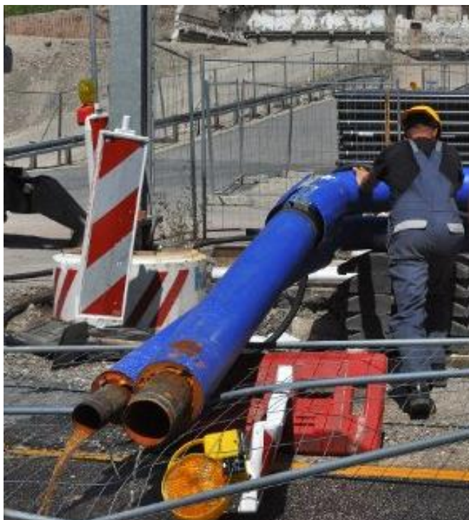
Aufnahmen: Andreas Rosar Fotoagentur-Stuttgart / veröffentlicht von STZ am 24.6.2014 Rostbrühe läuft aus Zuleitung zum Infiltrationsbrunnen. Rechts: Beachte die Rostspur am Boden!
