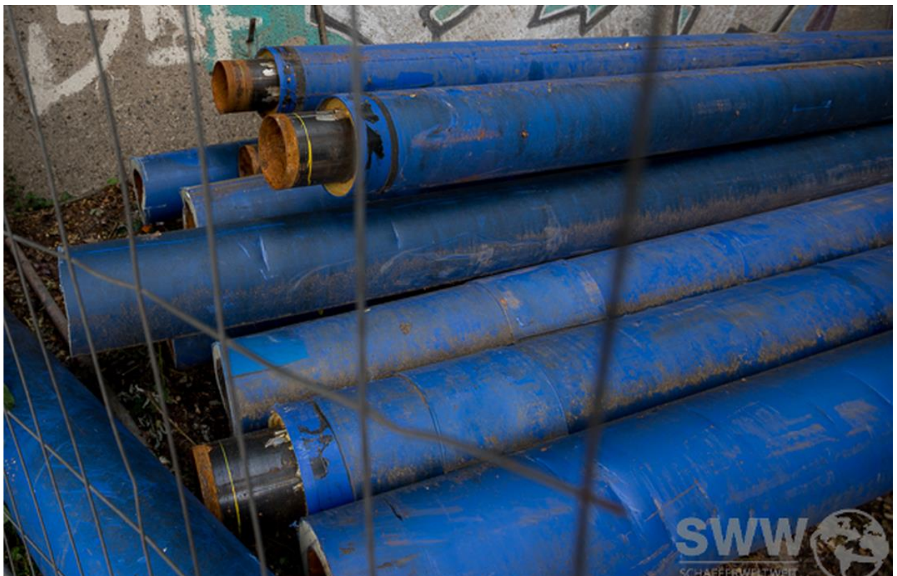
Bild 2: Ein Stapel der ausgebauten „Blauen Rohre“, z.Zt. gelagert an der Cannstatter Str. neben dem Bahn-Durchlass Abzweig Wolframstraße. Die erheblichen inneren Verrostungen der Rohre nach neun Jahren Einsatzzeit sind deutlich erkennbar.
