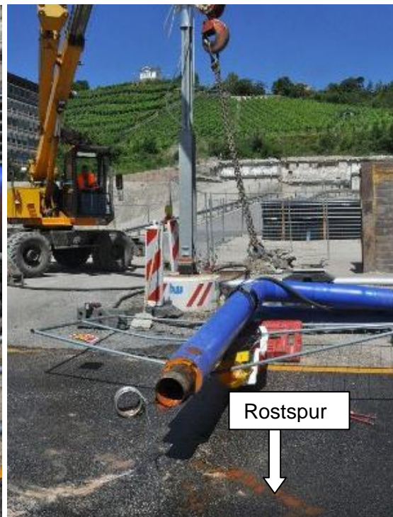
Aufnahmen: Andreas Rosar Fotoagentur-Stuttgart / veröffentlicht von STZ am 24.6.2014 Rostbrühe läuft aus Zuleitung zum Infiltrationsbrunnen. Rechts: Beachte die Rostspur am Boden!
